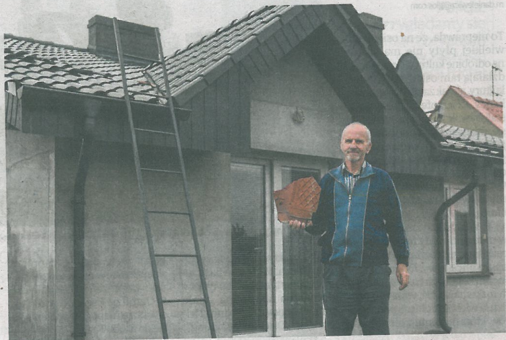
► Przelatujący samolot miał rzekomo uszkodzić ok. dwóch mkw. dachu pana Mieczysława
